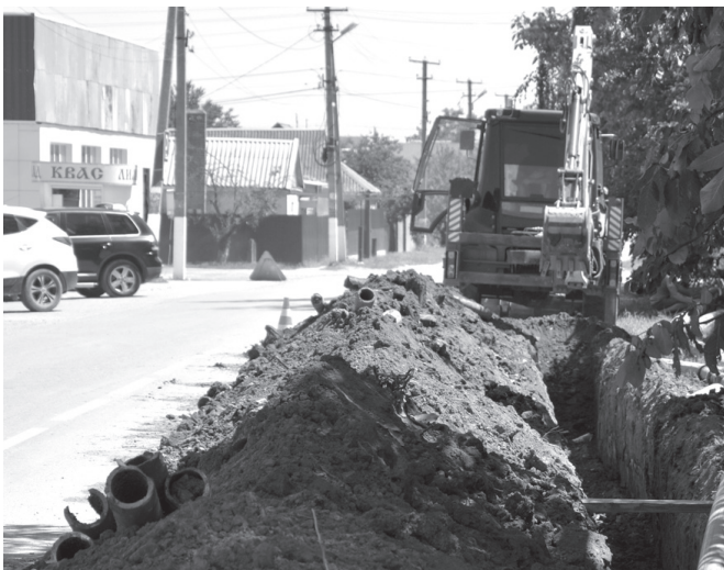
Строительство сбросного напорного коллектора по ул. Кубанской
